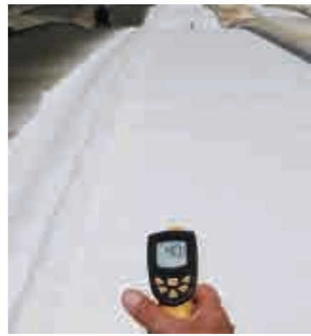
施作涼屋頂產品後的屋頂溫度
