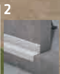
2 預製元件間連接縫 Sikadur-Combiflex® SG
