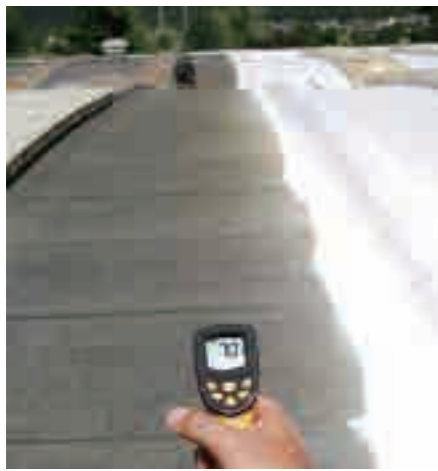
施作涼屋頂產品前的屋頂溫度
