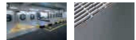
停車場地坪 伸縮縫地坪
