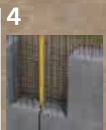
4 隔間牆施工縫 Sika® 止水帶
