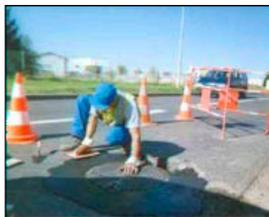
注意事項：拌合水之數量可以依據氣候狀況做些微調整，在乾燥與炎熱的天氣可能需要增加微量的水，在潮溼低溫的狀況下可能需要減少拌合水量。
