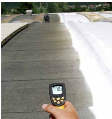
施作涼屋頂產品前的屋頂溫度
