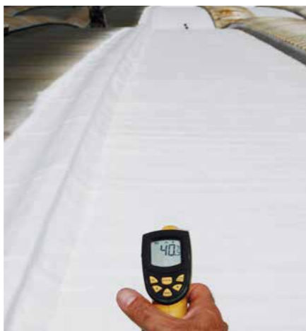
施作涼屋頂產品後的屋頂溫度
