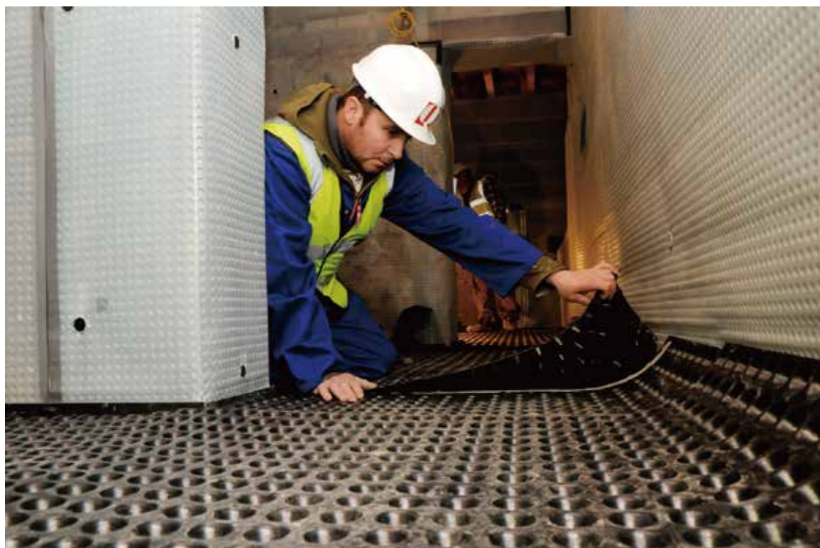
導水保護板 可用於搭配不同防水系統之保護板與防潮導水板。
