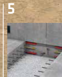
5 隔間牆地坪施工縫 SikaFuko®
