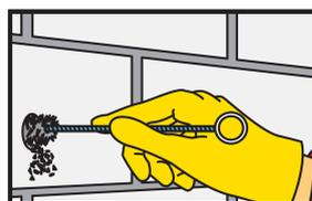
3. 鑽孔必須用專用鋼刷徹底清潔（至少刷 2 次）。刷子的直徑必須大於鑽孔的直徑
