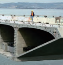
混凝土修補&剛性接著
