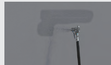
1. 以低壓噴塗或毛刷可輕易施工
