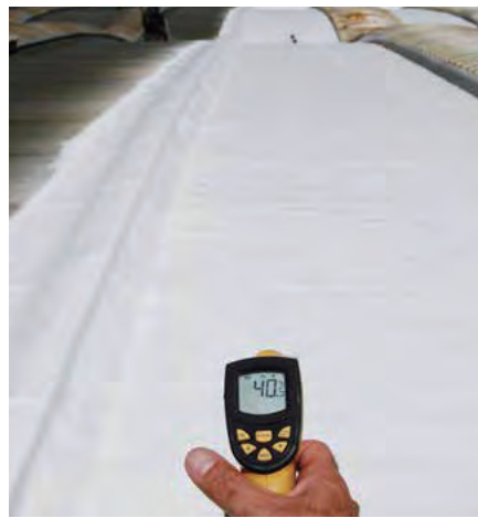
施作涼屋頂產品後的屋頂溫度
