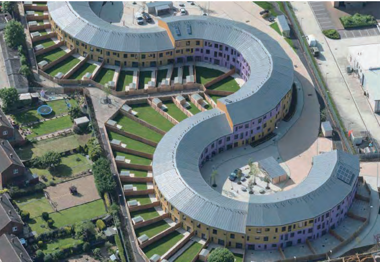
英國 THE SERPENTINE BUILDING
