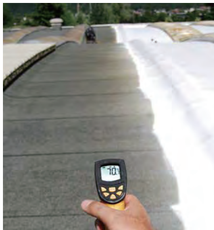
施作涼屋頂產品前的屋頂溫度
